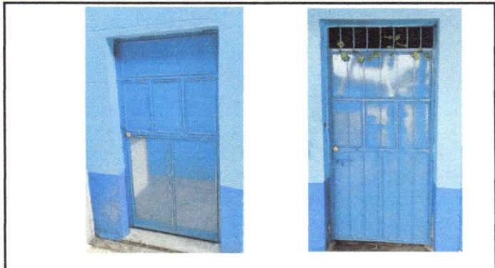
Foto 2: Sustitucion de Puertas de metal, Aulas.
