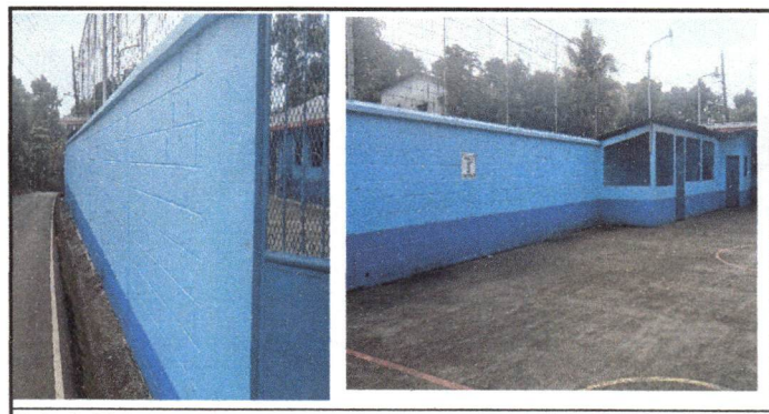
Foto 6: Pintura en muros exteriores e interiores del centro educativo
