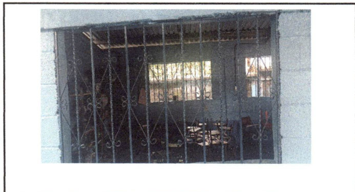
Foto 4: Mantenimiento a estructura de metal, Ventana de Aula
